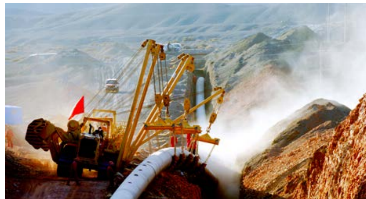
“西气东输”管道建设场景
