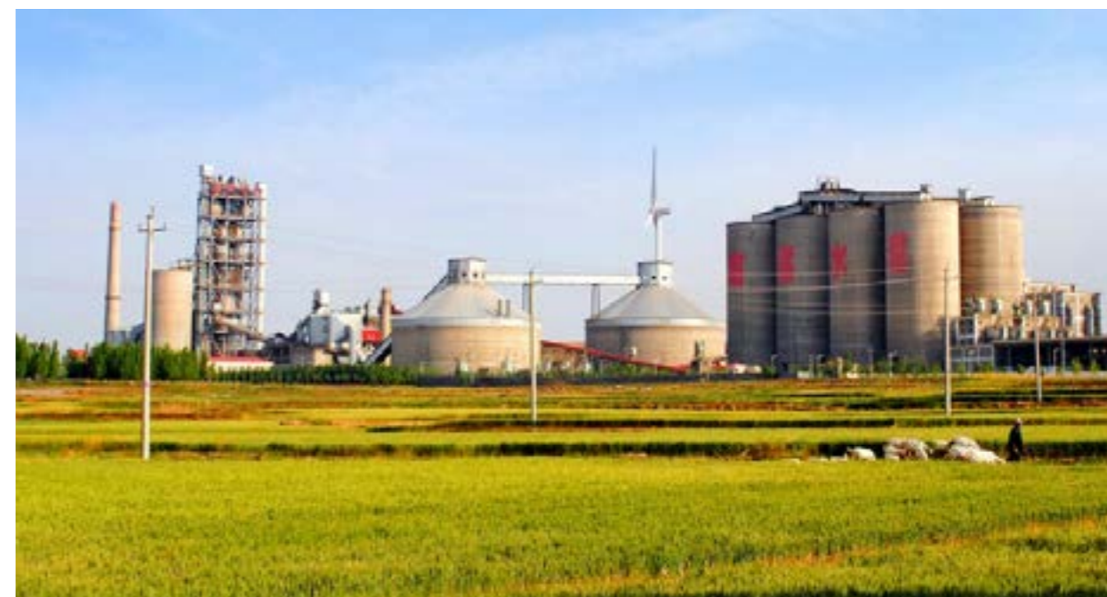
安徽分行支持的海螺集团余热发电设备
